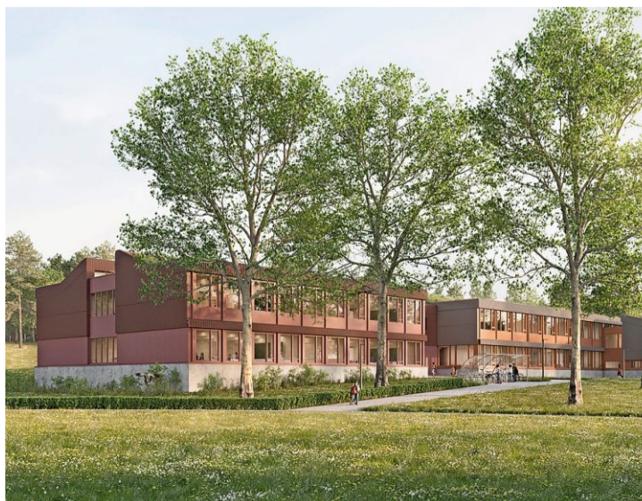
Der neue Schultrakt entsteht in vorfabrizierter Systemholzbauweise und umfasst zwei Geschosse. Visualisierung: Schwendener Partner AG
